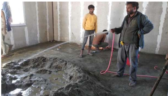
... die Bauarbeiten in vollem Gange ...
